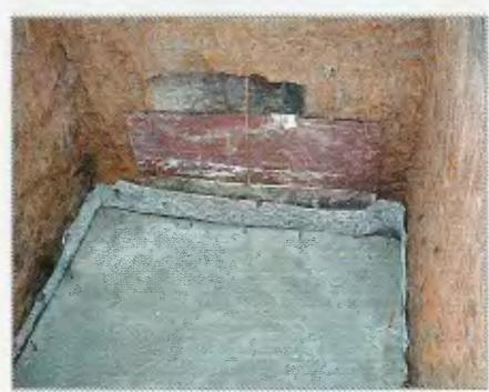
ней частично произошло биологическое разложение. Септики, предназначенные для двухсуточного выдерживания сточных вод, имеют, как правило, небольшой объём в противоположность многокамерным перегнивателям, предназначенным для 10-суточного пребывания воды. Сточные воды из септиков, рассчитанных на короткое время пребывания, не должны отводиться непосредственно в водоём, так как они не подверглись достаточной очистке."
