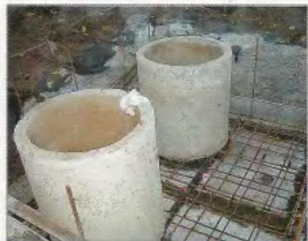
Ответственный этап работы — армирование перекрытия и установка колец горловин.
