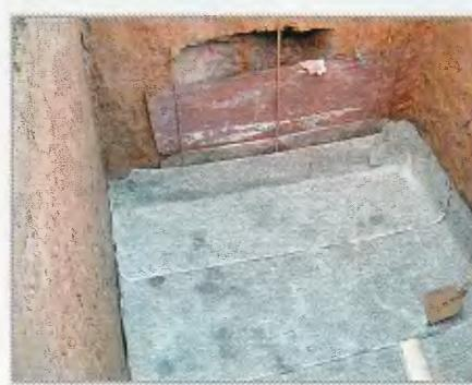
Устройство днища септика. На дно котлована укладывают слой рубероида, загибы которого не дадут «цементному молочку» впитаться в грунт, а затем укладывают арматуру и заливают бетон.
