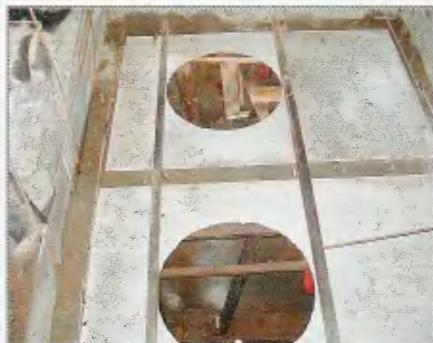
Опалубка перекрытия также выполнена из асбоцементных плит. В местах установки колец горловины в них заранее делают отверстия.
